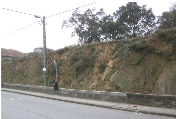
Figura 58 – Afloramento rochoso com evidência da escassez de solo, localizado na envolvente na área em estudo.
